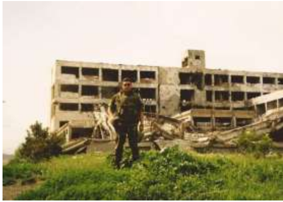
Tracce di distruzione in Kosovo
